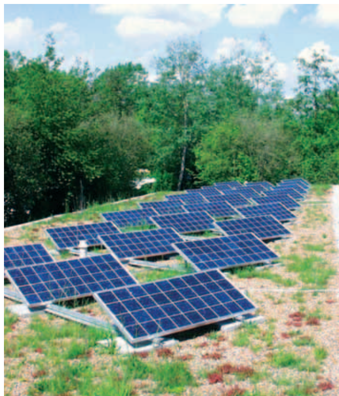
Auch der Campingplatz Klausenhorn erzeugt mit Solarzellen auf dem begrünten Dach einen Teil des benötigten Stroms selbst.
