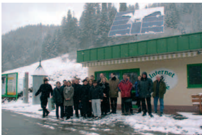
Als die nachgeführten Solaranlage auf dem Campingplatz Kleinenhof eingeweiht wurde, feierten die ECOCAMPING-Kollegen mit. Im Winter muss im Schwarzwald so manches Mal der Schnee von den Solarmodulen abgefegt werden. Doch dann produziert die Anlage selbst bei Minusgraden Strom.
