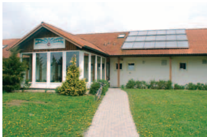
Solardach auf dem Campingplatz Arterhof in Bad Birnbach.
