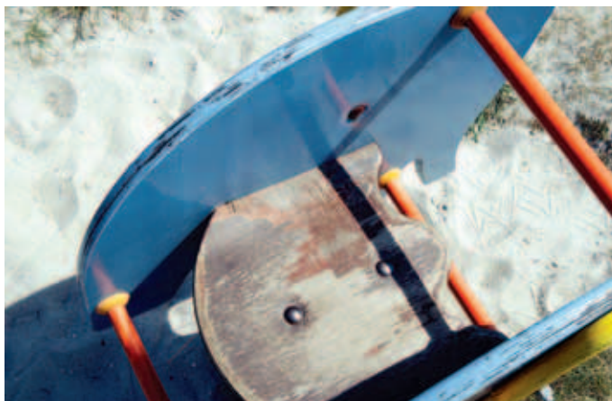
Ist der Sitzflächenbelag abgesplittert, muss er ausgewechselt werden.
