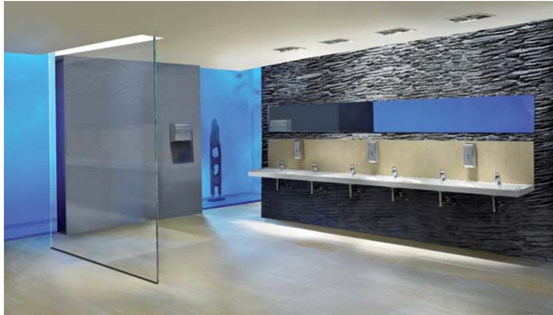
Waschraum mit zwei Reihenwaschtischen jeweils als Dreier-Einheit aus dem neuen Verbundwerkstoff MIRANIT.
