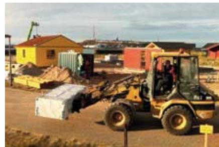
Baustelle mit 7cm starken Fassadenbohlen vor dem gedämmten Ständerwerk und in Einzelteilen montiert. Dadurch kann auch auf schwer zugänglichen Plätzen, die durch keinen Kran erreichbar sind, problemlos gebaut werden. Das erschließt manchem Campingplatz neue Baumöglichkeiten. Die Wohnhäuser und weitere Informationen zum Unternehmen sind unter [www.fjorborghaus.de](http://www.fjorborghaus.de) zu finden. Ansprechpartner ist der Geschäftsführer Thomas Stöckmann.
